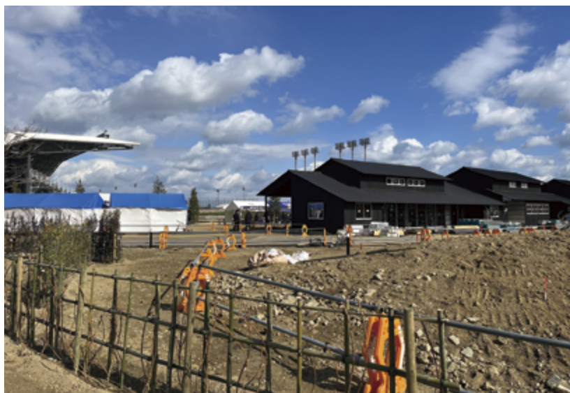
整備中の(仮称)里山スタジアムと来島会の福祉施設
